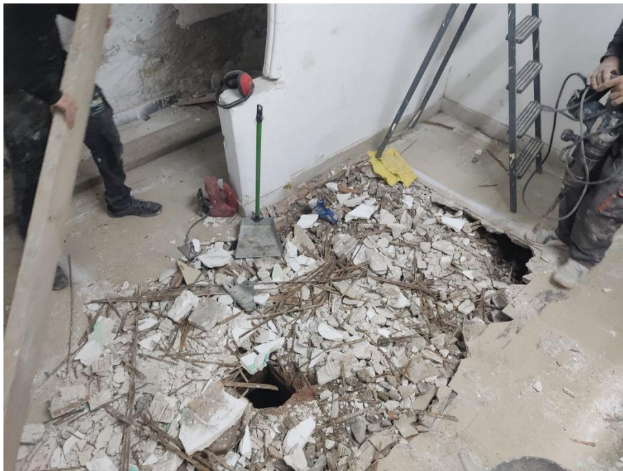
Figura 3. Retirada del suelo (UE1/UE2).
